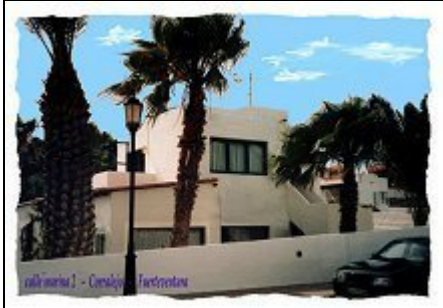
Casa Monterojo - Südansicht
