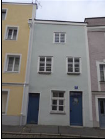
Straßenansicht Ferienhaus Löwengrube
