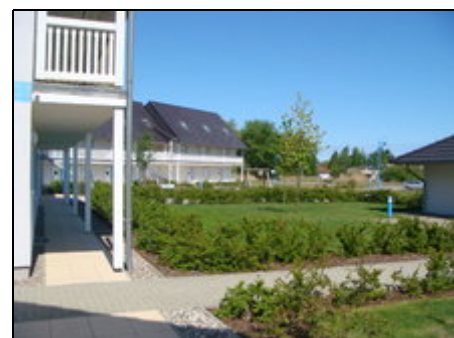
Rückseite der Anlage
