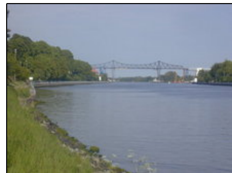
Hochbrücke mit Schwebefähre am NOK
