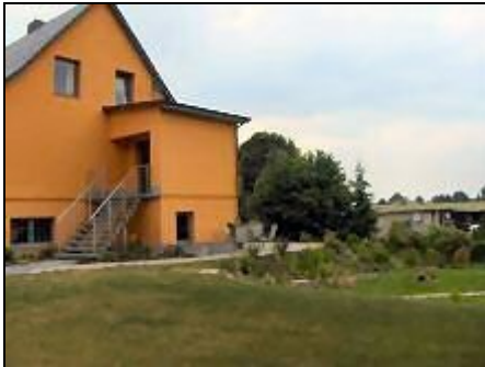
Blick auf den Eingang
