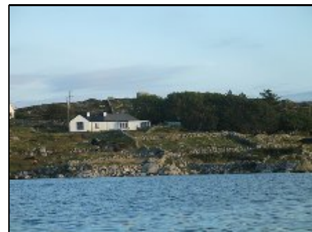
Blick von der Seeseite
