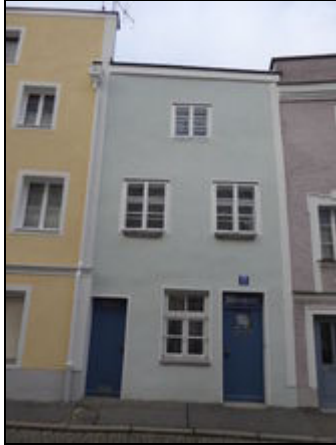
Straßenansicht Ferienhaus Löwengrube
