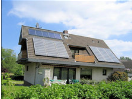
Ansicht aus Süd-/Westlage
